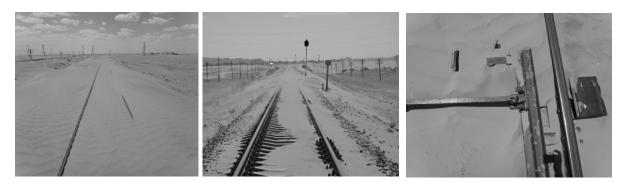
Fig. 1. Problems of sand drifts Рис. 1. Проблемы песчаных заносов
